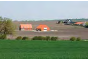
| Hinding. Nyt bygningsanlæg i landbrugslandskabet.
