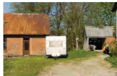
| Hørsted. Forfaldne landsbyhuse, der venter på nye kræfter.
